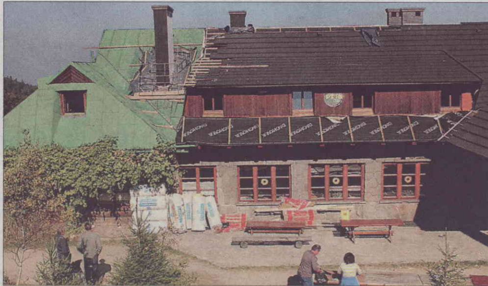
Właśnie remontowane jest schronisko na Hali Łabowskiej ZDJ. EDYTA ZAJĄC
